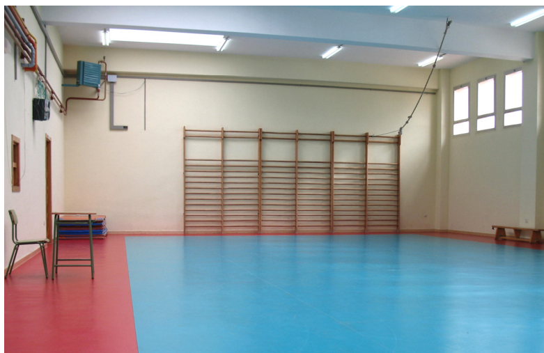
Nuevo pavimento y claraboyas en el gimnasio
